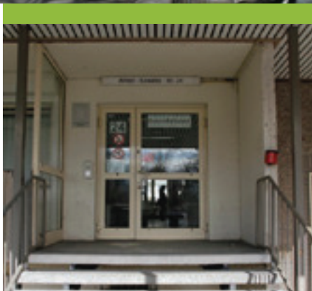
Der Sitz des Gesundheitsamtes Berlin-Lichtenberg in der Alfred-Kowalke-Straße. Das Gebäude, ursprünglich als Altenpflegeheim geplant, muss bald renoviert werden.
